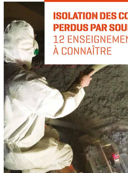
En l'absence de coffrage, l'isolant biosourcé en vrac est au contact direct du conduit de cheminée. Cette configuration n'est pas réglementaire et peut être à l'origine d'un départ de feu. ©AQC
