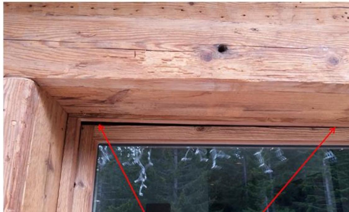
Ferrures se désolidarisant du dormant et de l'ouvrant entraînant un affaissement de la porte fenêtre
