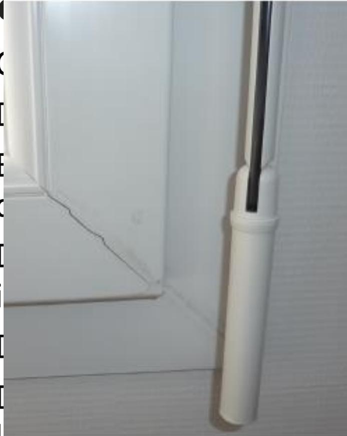
Rupture de soudure d'un angle de cadre PVC.
