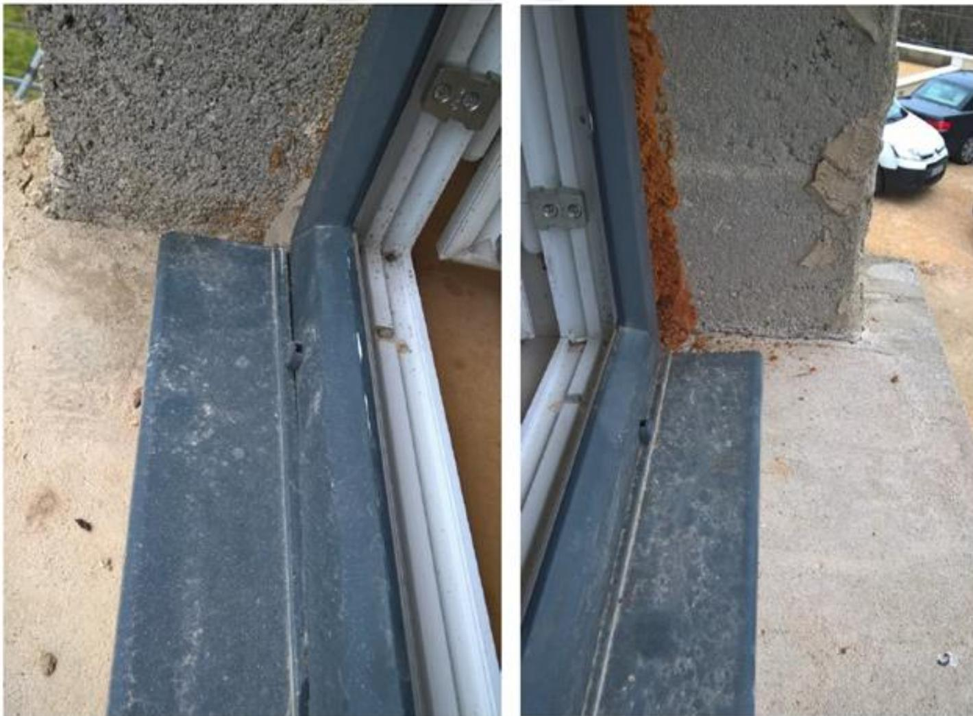
Fenêtres posées sans rejingot et calfeutrement avec mousse expansive
