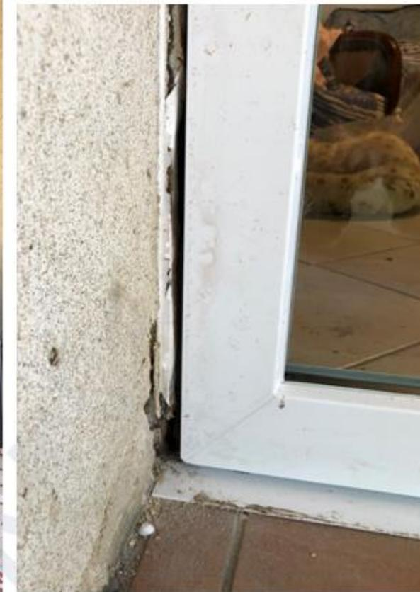
Porte fenêtre posée en rénovation avec dépose totale de l'ancienne fenêtre. Sans reingot et sans reprise des supports (source ACOUSTB)
