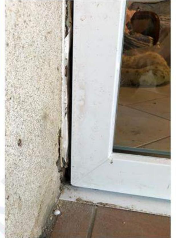
Porte fenêtre posée en rénovation avec dépose totale de l'ancienne fenêtre. Sans reingot et sans reprise des supports (source ACOUSTB)
