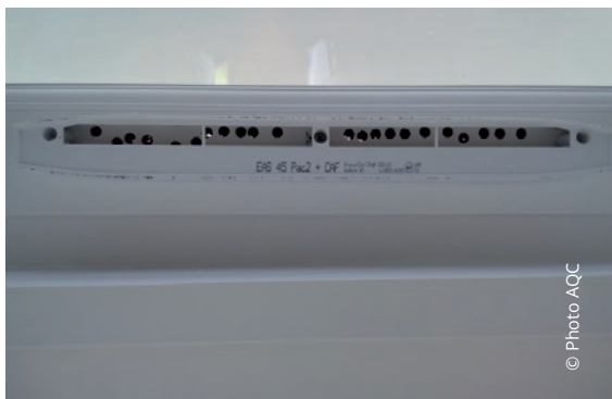
✗ Absence de mortaise pour l'entrée d'air
