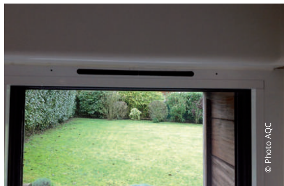
✓ Mortaise réalisée selon les règles de l'art
