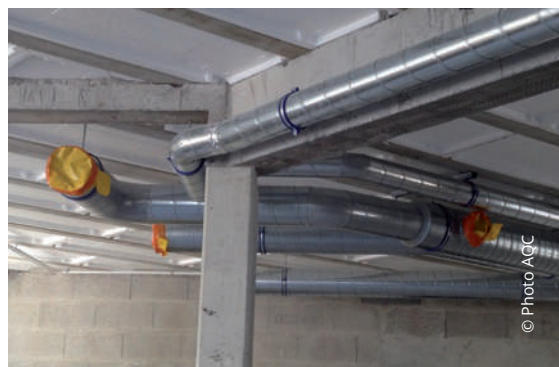
✓ Réseau aéraulique installé selon les règles de l'art bas dans le réseau aéraulique
