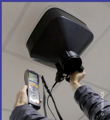
✓ Mesure de débit aux bouches d'extraction.
