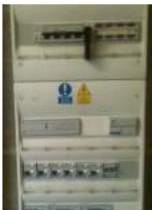
Les onduleurs sont branchés sur le tableau électrique puis raccordés au réseau électrique de distribution. C'est sur le tableau électrique que l'on peut voir l'état des éléments de protection.
