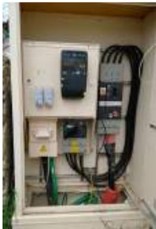
Le PDL représente le point de raccordement de l'installation photovoltaïque au réseau électrique public, il est matérialisé par le compteur de production.
