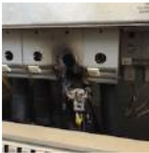
Si l'installation produit normalement mais que des éléments semblent fondus au niveau des connexions (onduleurs, panneaux PV, câbles), arrêtez l'installation photovoltaïque (disjoncteur général de l'installation) et contactez rapidement un installateur photovoltaïque pour diagnostiquer l'origine du problème et changer les pièces.
