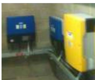
Les modules sont branchés via les coffrets CC aux onduleurs pour convertir le courant continu en courant alternatif.
