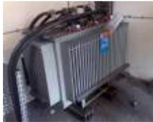
Si la puissance de l'installation est supérieure à 250 kVA, le raccordement au réseau public se fait en HTA (moyenne tension). Le poste de transformation, privé dans ce cas, permet d'élever la tension pour pouvoir raccorder cette installation (qui délivre de la basse tension) sur le réseau électrique HTA.
