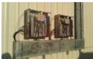
L'ensemble des chaînes est branché dans un coffret CC ou DC avant d'être raccordé à l'onduleur, c'est dans ce coffret que se fait la mise en parallèle des séries de modules pour l'addition du courant.
