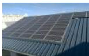
Les modules sont raccordés en série sur une ou plusieurs entrées de l'onduleur : cette série de modules peut être appelée chaîne de modules, série de modules ou string.
