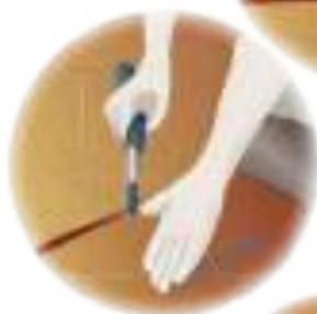
3. Souder les angles avec une buse à col de cygne ou de finition
