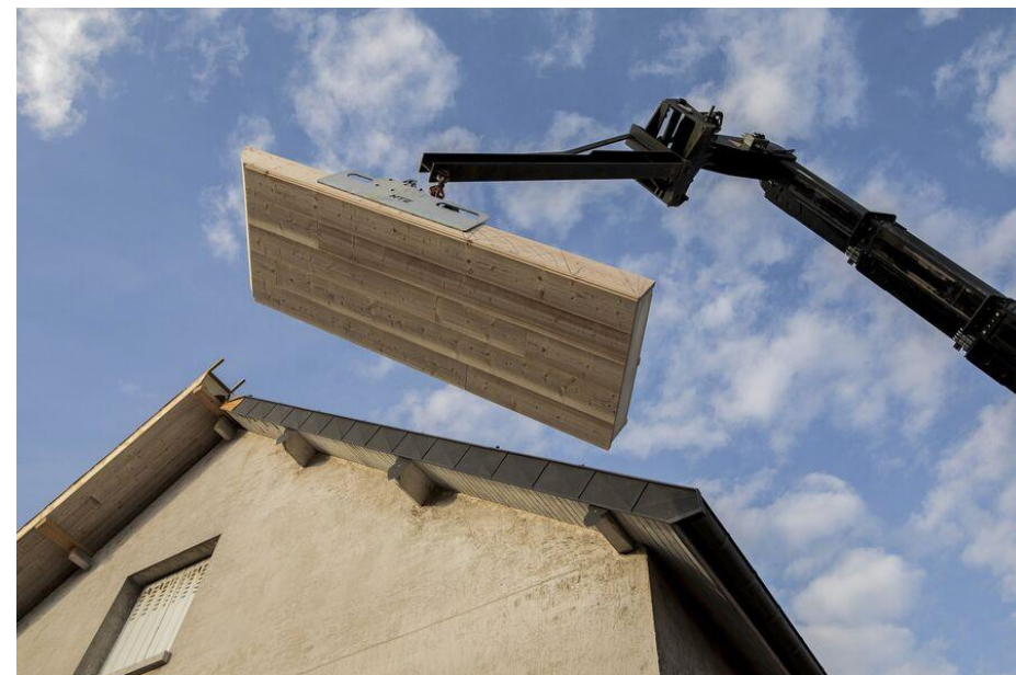
Levage d'un caisson traditionnel
